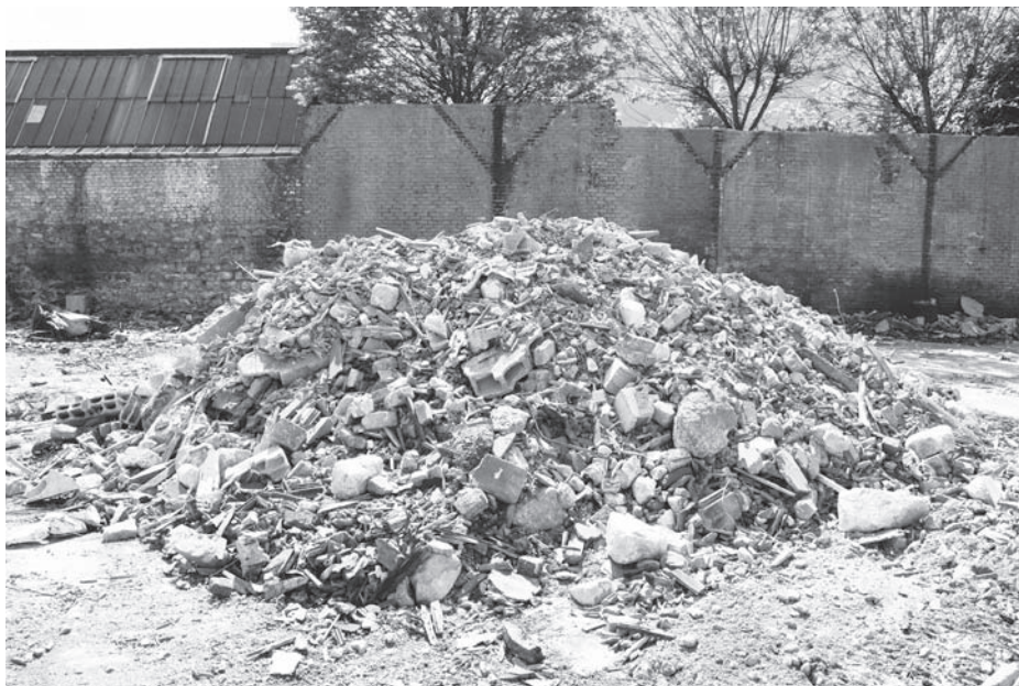
Démolitions, ZAC du Plateau, 2008
